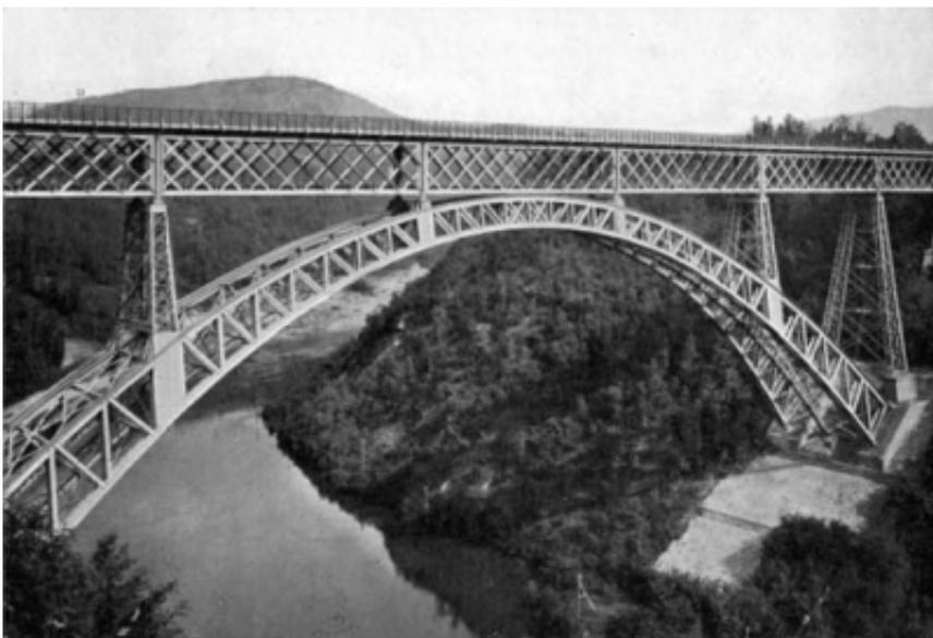
5. Il ponte di Paderno sull'Adda. (R. R., *Industrie moderne...*, p. 455) "un viadotto metallico che scavalca il fiume con una sola arcata, la quale sorregge la parte centrale della travata. Se per le portate relativamente brevi è notevole l'introduzione del cemento armato, è soprattutto nei ponti metallici che si sono verificati in questi ultimi anni i maggiori progressi in dipendenza dei progressi nella produzione e nell'impiego dell'acciaio". (R. R., *Industrie moderne...*, p. 453).
